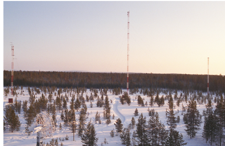
Sodankylän geofysiikan observatorion ionosondin antennimastot. Keskimääräinen masto on 64 metriä korkea. (Kuva: Jyrki Manninen)
